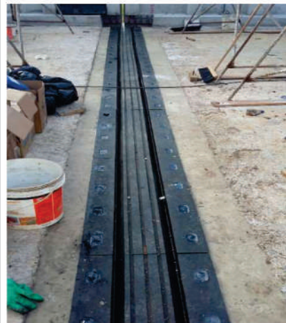
VISTA DA JUNTA FINALIZADA JÁ COM OS FUROS PREENCHIDOS C/ EPÓXI
