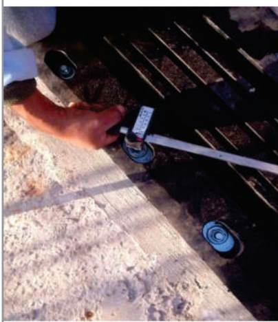
APERTO DAS PORCAS DOS CHUMBADORES COM CHAVE TORQUIMÉTRICA
