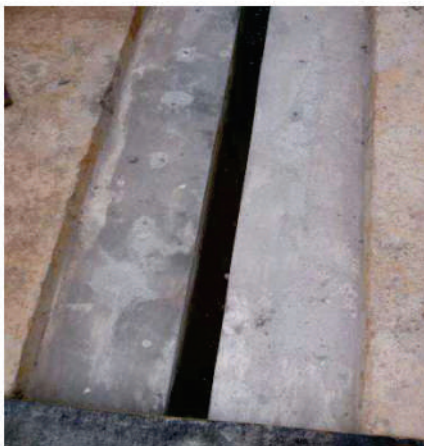
COLOCAÇÃO DOS MÓDULOS DE JUNTA NO BERÇO
