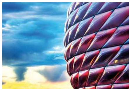
APARELHOS DE APOIO ESTRUTURAIS
