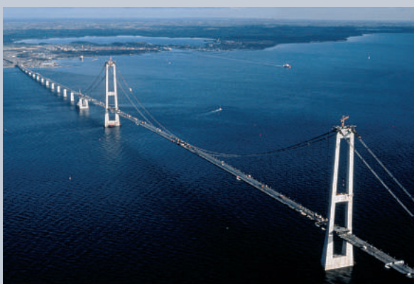
Ponte Storebælt, Dinamarca Construída em 1996 Comprimento do vão: 1624 m Junta de Dilatação do tipo: DS 2000 – 51,40 m DS 1520 – 25,70 m DS 1200 – 25,70 m DS 960 – 25,70 m DS 800 – 25,70 m
