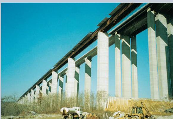
Stura di Demonte, Itália Viaduto construído em 1999 Comprimento: 2750 m Juntas de Dilatação do tipo: DS 1200 – 24,50 m
