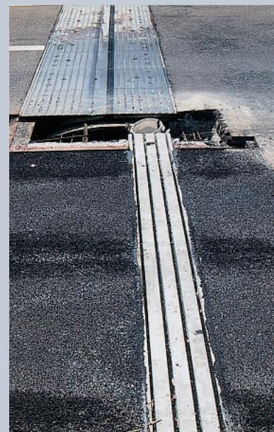
Substituição das juntas de dilatação existentes pelas juntas articuladas oscilantes
