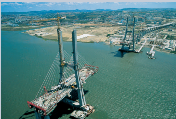
Ponte Vasco da Gama, Portugal Juntas equipadas com o sistema de ruptura predeterminado Ponte Estaiada construída em 1997 Comprimento do vão: 829 m Juntas de Dilatação do tipo: DS1440 – 59,00 m
